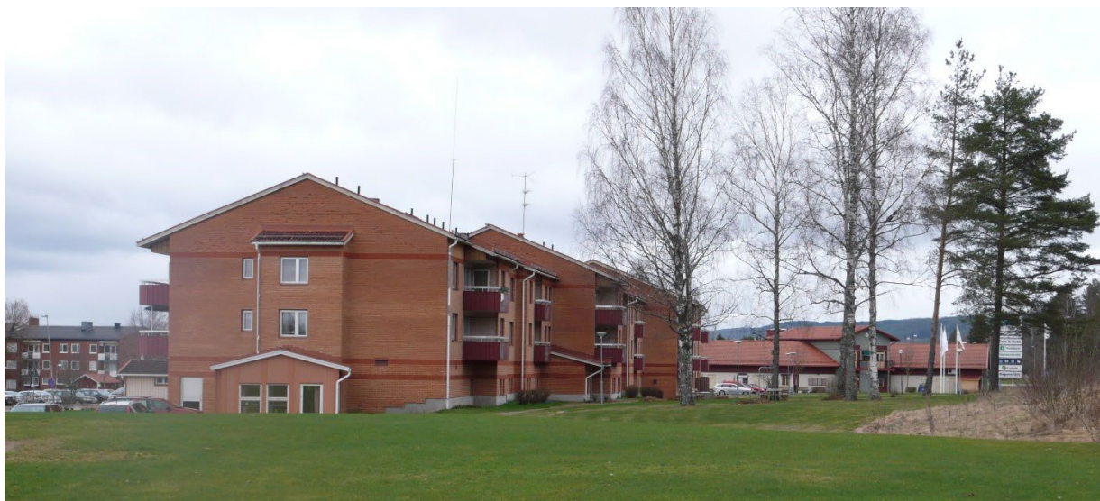
Byggnaden sedd från söder
