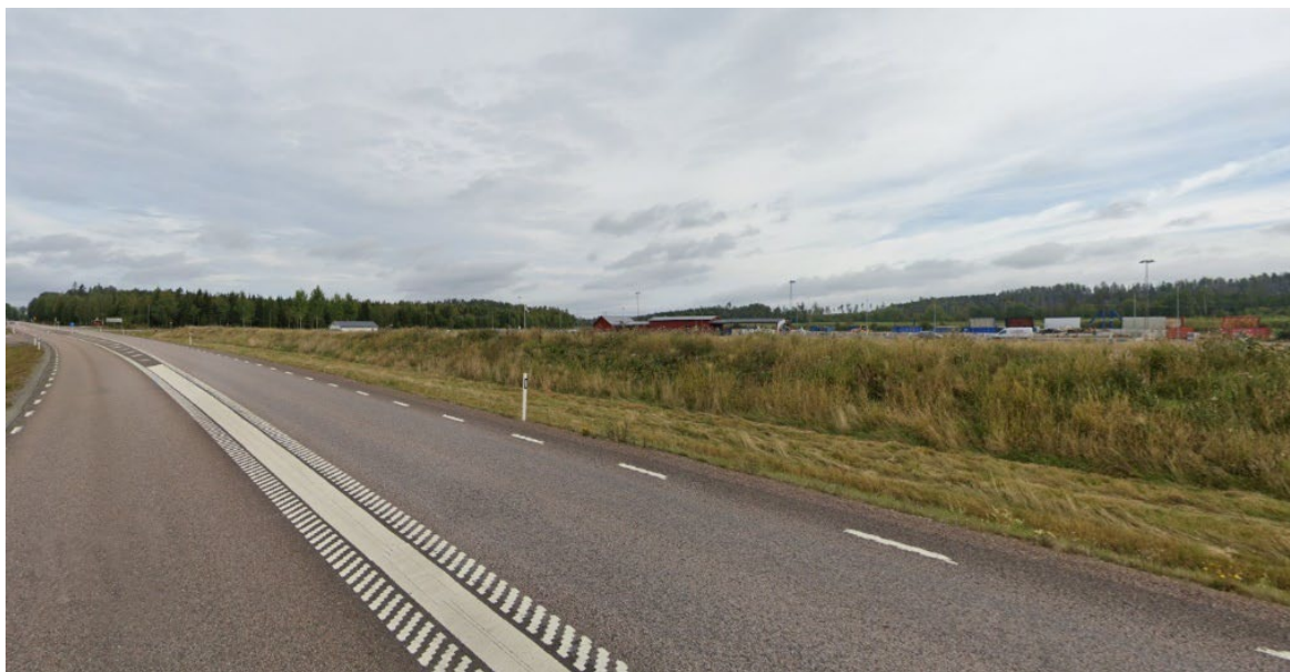
Riksväg 62 utmed området idag. Vallen skyddar området från avåkande fordon (bild: Google)
