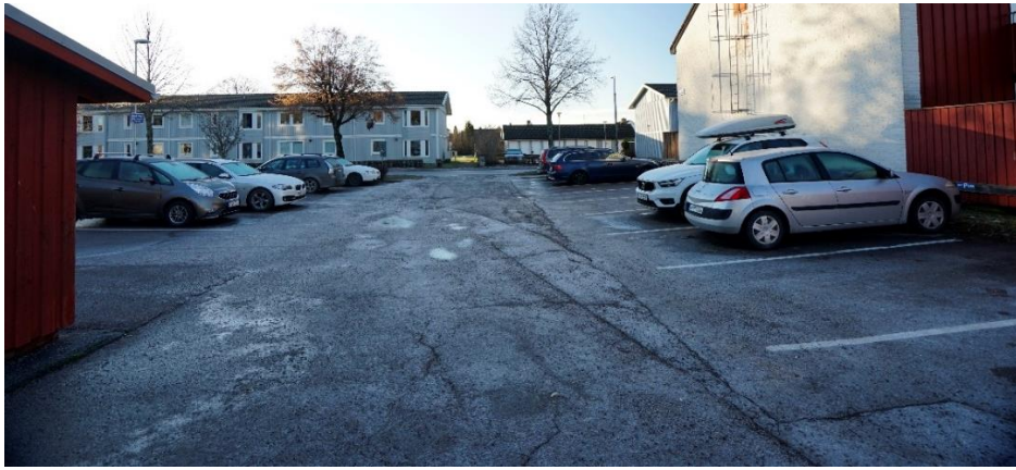
Befintlig parkering inom Svanden 8
