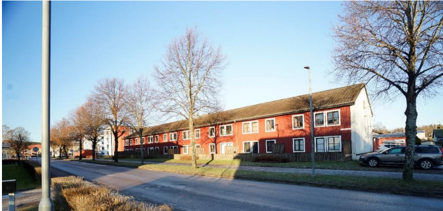
Befintligt tvåvåningshus inom Svanen 8
