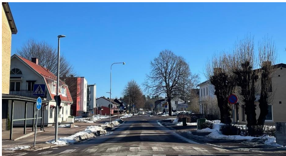
Bruksgatan sett från korsningen Storgatan/Bruksgatan
