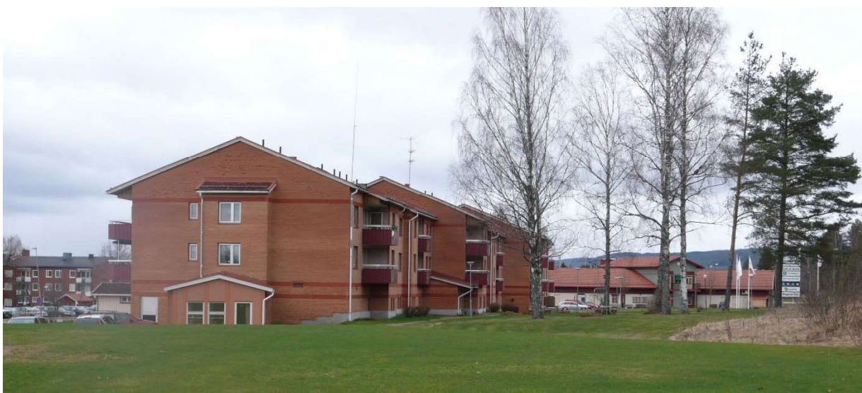
Byggnaden sedd från söder
