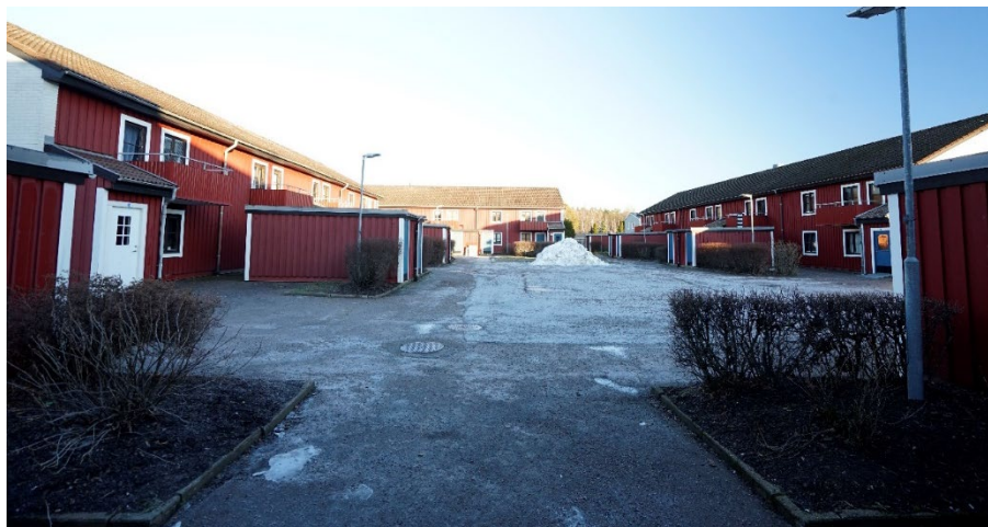
Bilden visar hur bostadsområdet Svanen 8 ser ut idag. Den asfalterade ytan och förrådsbyggnaden har förutsättningar för att omgestaltas till gårdsyta
