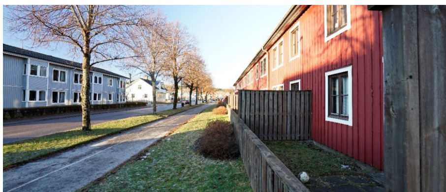
Trädallén intill Svanen 8 och befintliga uteplatser vid gång- och cykelbanan
